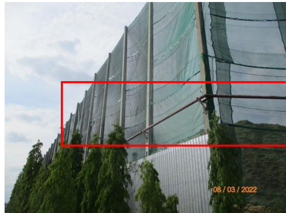
รูปที่ 47 ท่อฉีดน้ำดับเพลิงรอบกองขนถ่าย
