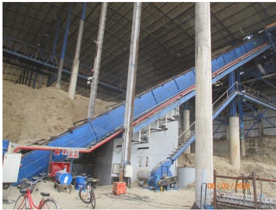
รูปที่ 47 ท่อฉีดน้ำดับเพลิงรอบกองขนถ่าย
