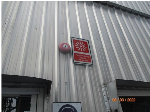
รูปที่ 45 ระบบแจ้งเหตุเพลิงไหม้/ระบบเตือนภัย
