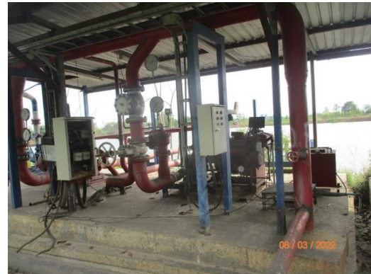
รูปที่ 46 เครื่องสูบน้ำดับเพลิง
